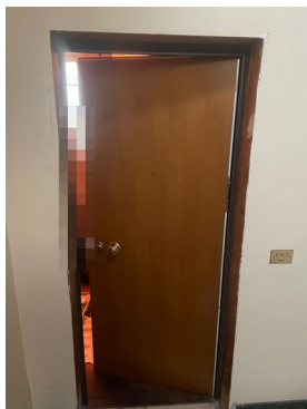
Foto 1: porta completa — esterno
